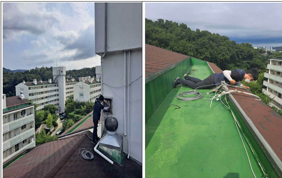
[그림 4-6] 케이블·통신 설치 업무 과정
